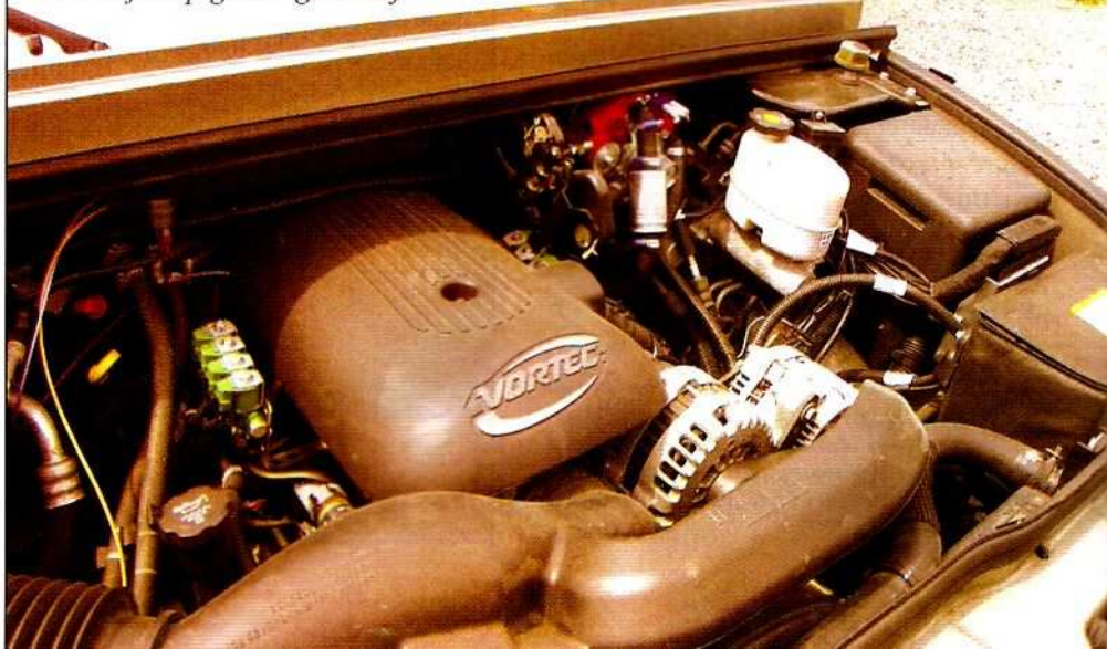
Instalacja Elpigaz IV generacji
